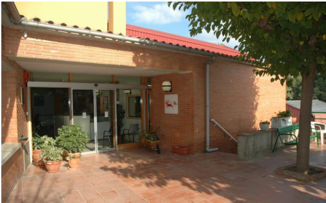
Accés edifici Taller CO-CET
